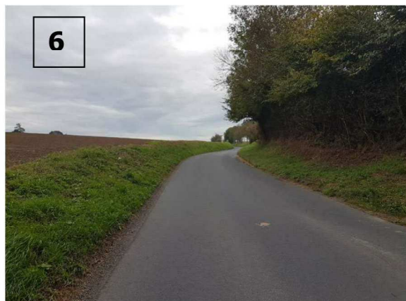
Vue sur la Rue de Caen – RD n°221, vers le Sud-Ouest
